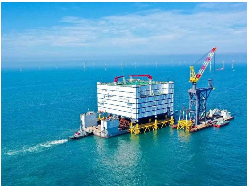
振华重工项目团队自主研发多项关键技术，实现了超大跨距分体式导管架海上精度安装、一体式 DSF 设计、荷载受限码头分载及换流站海上毫米级精确对接，解决了世界最大换流站的制造、运输、海上浮托安装难题。该项目共申请了 4 项发明专利和 6 项实用新型专利，目前已取得 2 项发明专利和 6 项实用新型专利的授权，项目成果已刊发核心期刊论文 2 篇。中国电力建设企业协会评价本项目成果的意见为，项目关键技术达到国际领先水平。
